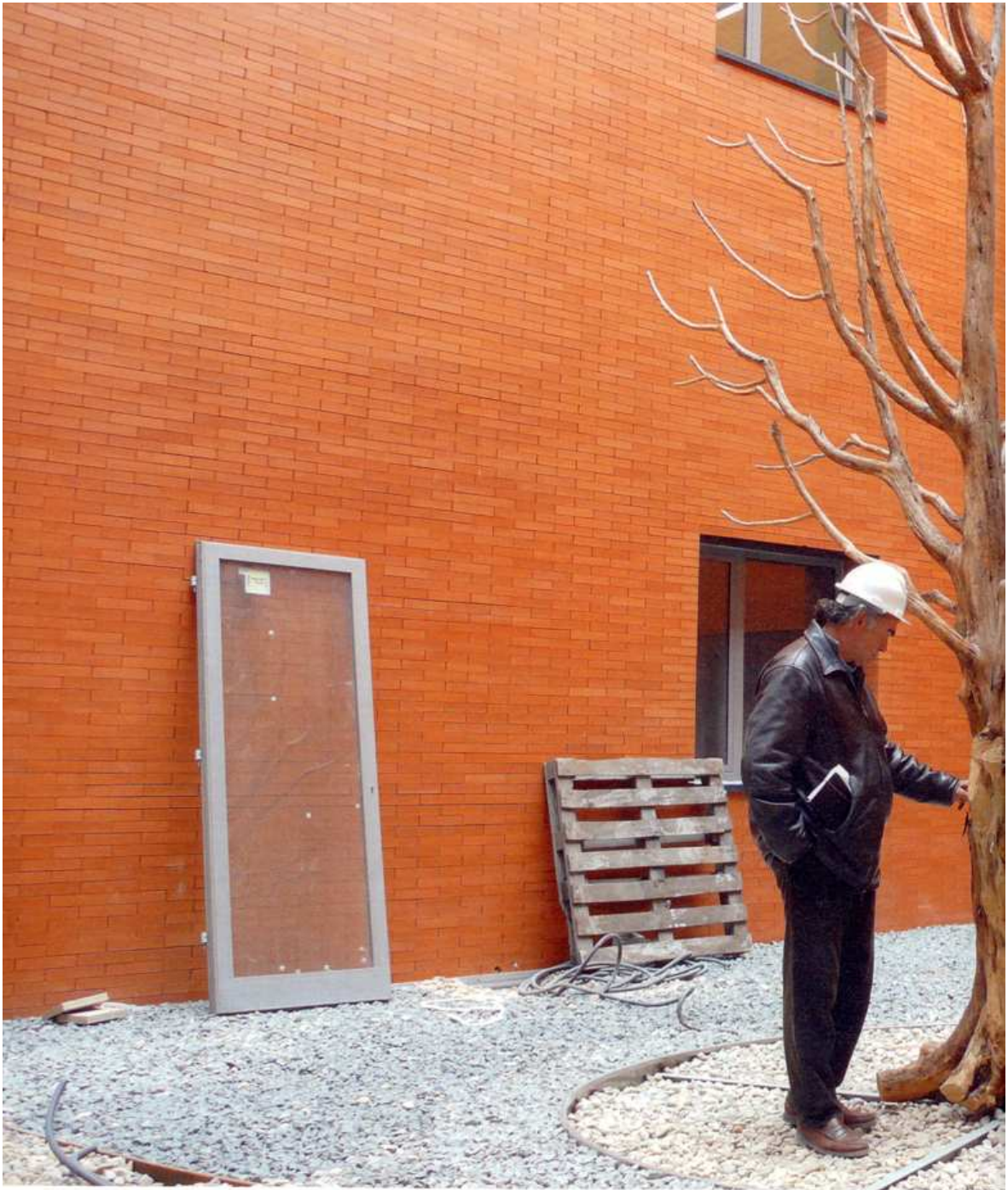
El jefe de obra, Juan Manuel Sánchez, supervisa con el paisajista, Luis Vallejo, la instalación de una sabina albar seca.
